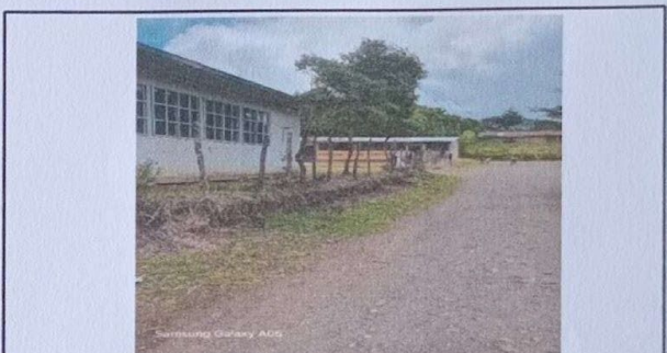
Foto 4: MEJORAMIENTO DE MURO PERIMETRAL
