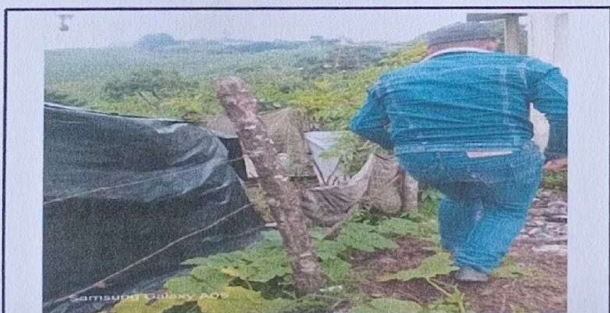
Foto 5: MEJORAMIENTO DE MURO PERIMETRAL
