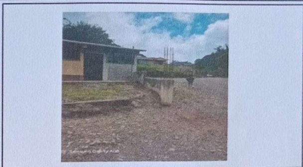
Foto 2: MEJORAMIENTO DE MURO PERIMETRAL
