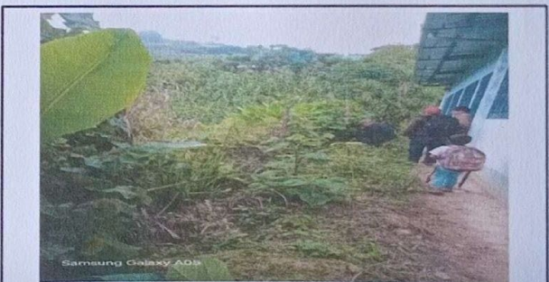
Foto 6: MEJORAMIENTO DE MURO PERIMETRAL
